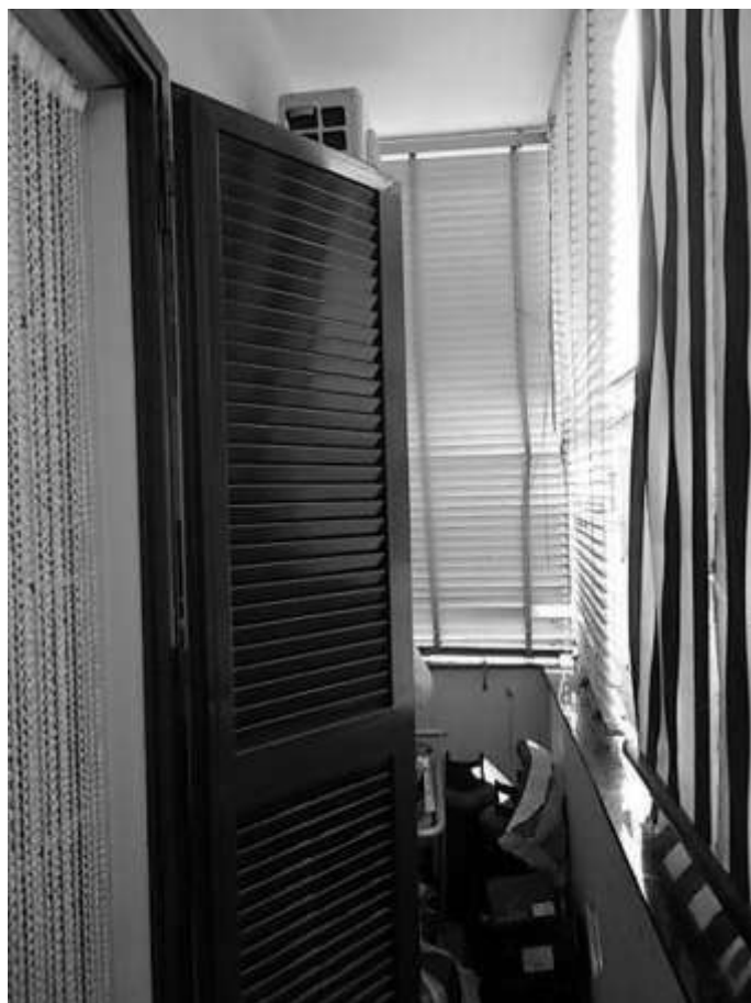
balcone al piano primo
